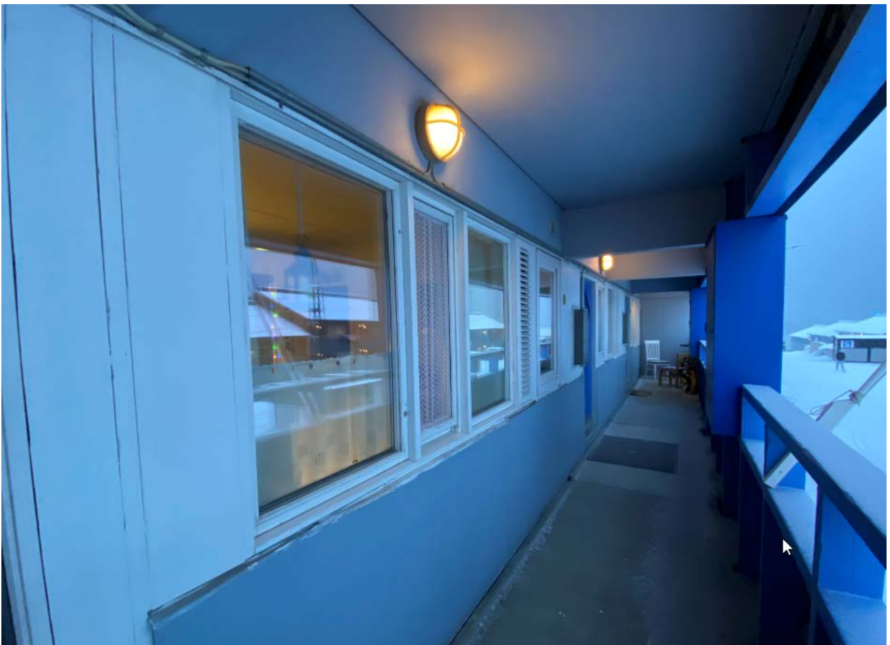
Vinduer i svalegang, facade mod nord.
