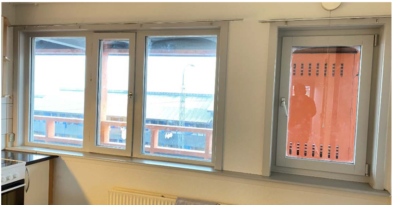
Eksisterende vinduer i køkken, facade mod nord
