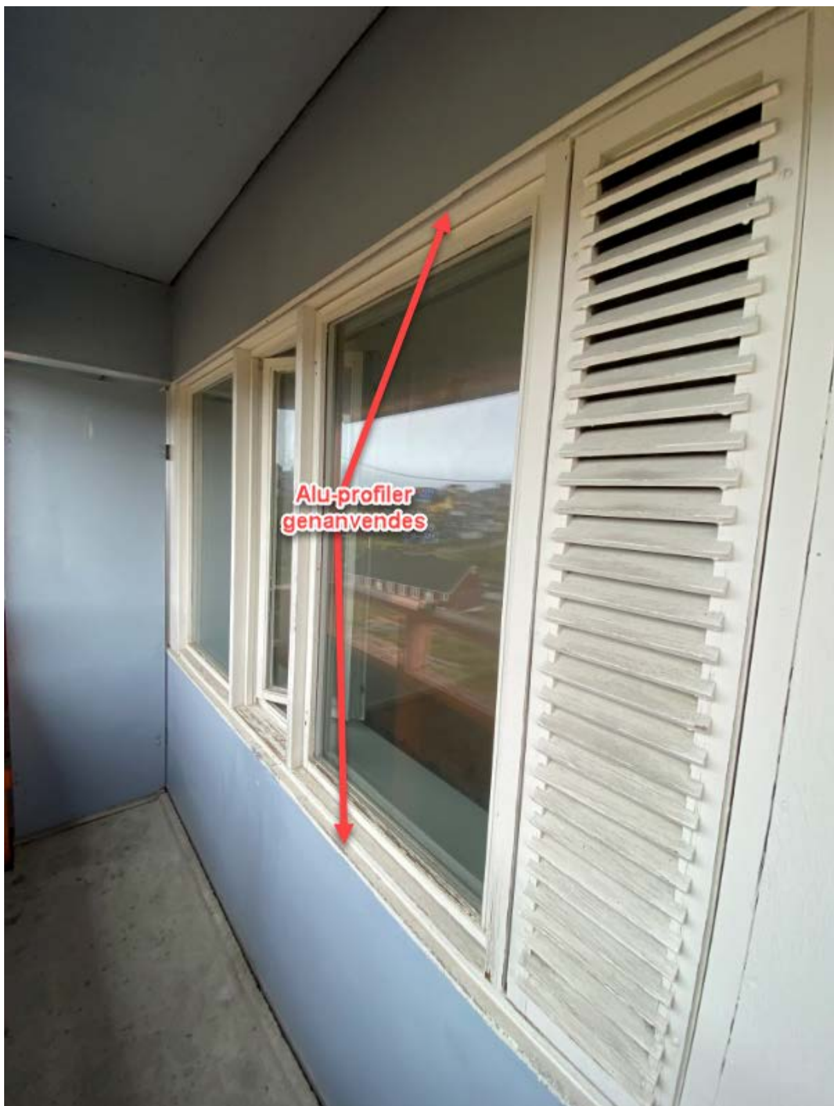
Vinduer i soveværelse, facade mod syd
