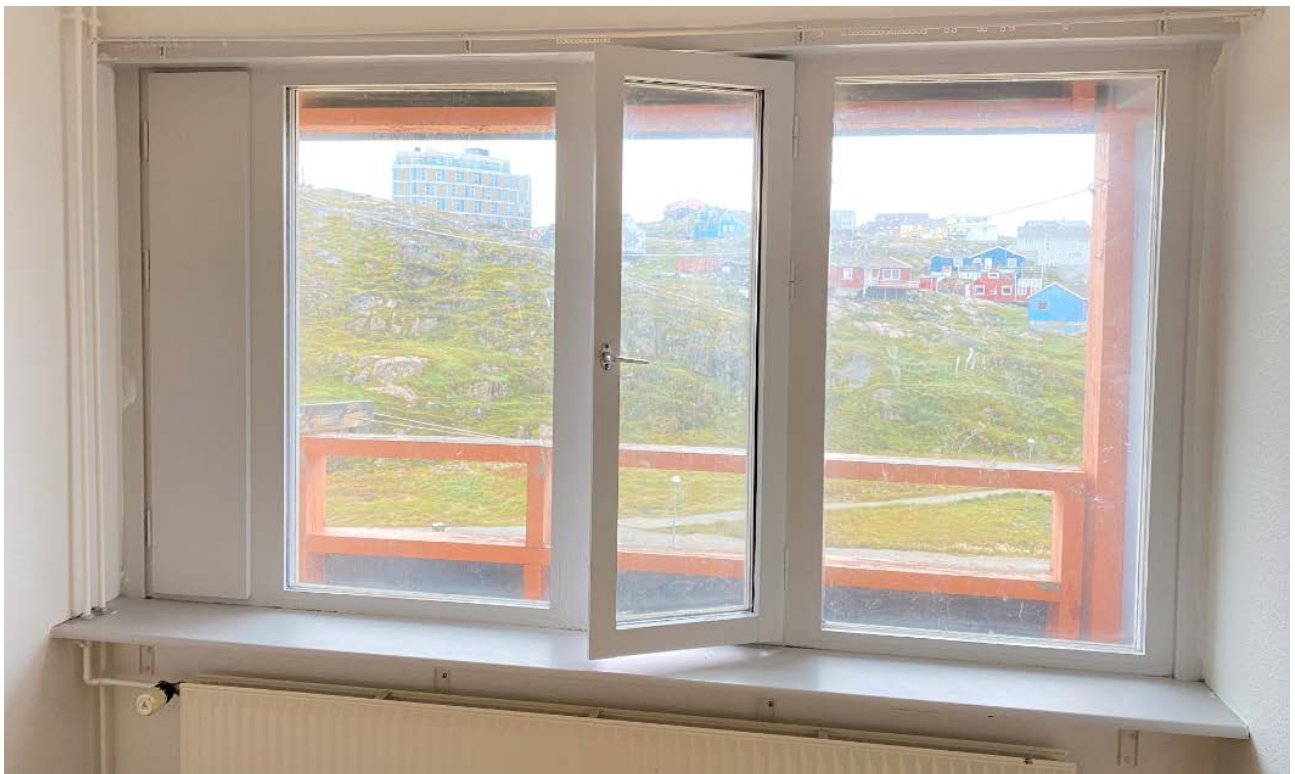
Eksisterende vinduer i soveværelse, facade mod syd
