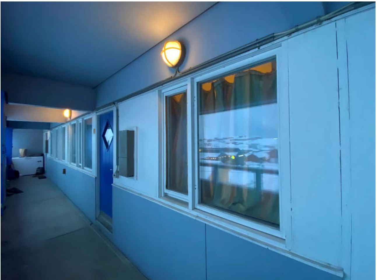
Vinduer i svalegang, facade mod nord.
