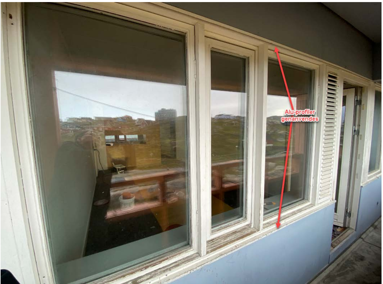
Vinduer og altandør i opholdsstue, facade mod syd
